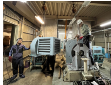
【整備画像】ゴンドラリフト 電動機OH
